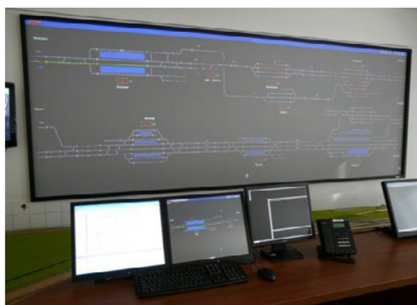
Obr. 5 Jednotné obslužné pracoviště (JOP) elektronického zabezpečovacího zařízení
